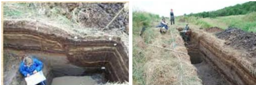
Gambar 4.5. Pembuatan parit uji dengan kedalaman 50 cm
