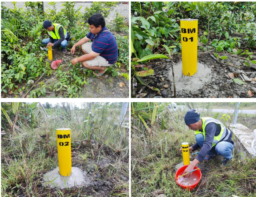
Gambar 5.2 Pemasangan Patok BM pada Lokasi Study
