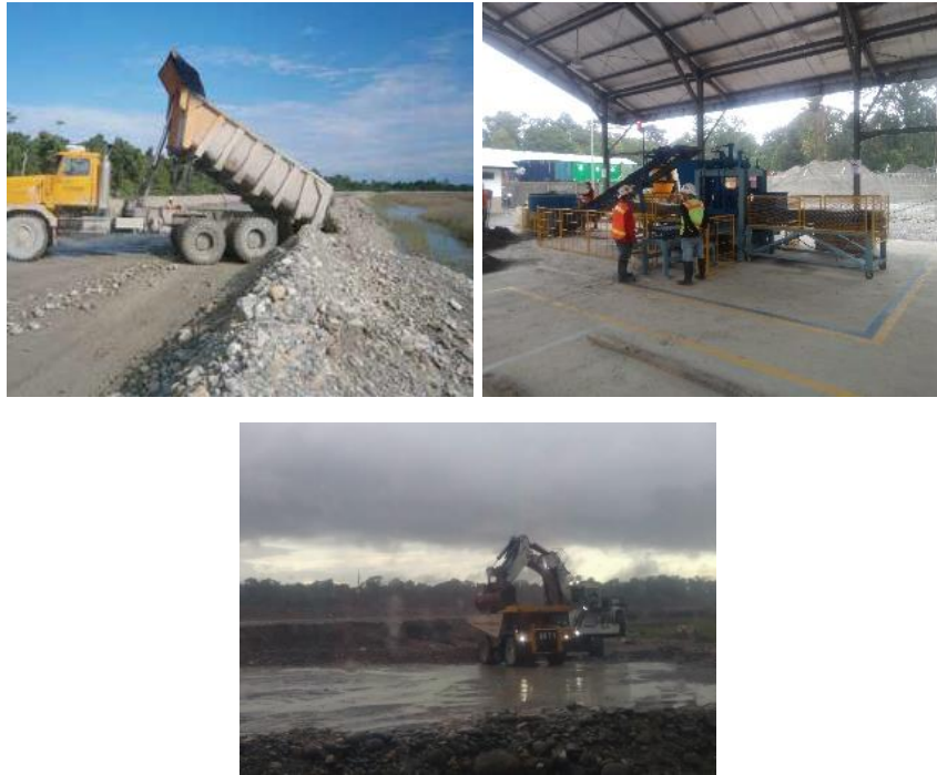
Gambar 3-9 Perbaikan Tanggul di ModADA (Kiri) dan Pengolahan Tailing di Workshop Tailing Utilization (Kanan), serta Pengambilan dan Pengangkutan Tailing di ModADA
