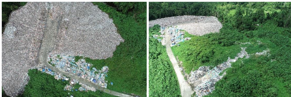
Gambar 5.9 Kondisi TPA Iwaka
